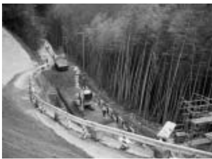
山鳥坂ダム建設に向け着工した 関連工事
