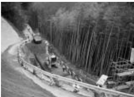
山鳥坂ダム建設に向け着工した関連工事
