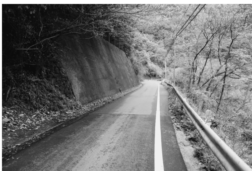
肱川・河辺地区の主要道路、県道小田河辺大洲線 (肱川地区・山鳥坂)
