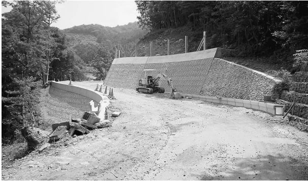
厳しい財政状況の中推進される市道改良工事（長浜地区…黒田）
