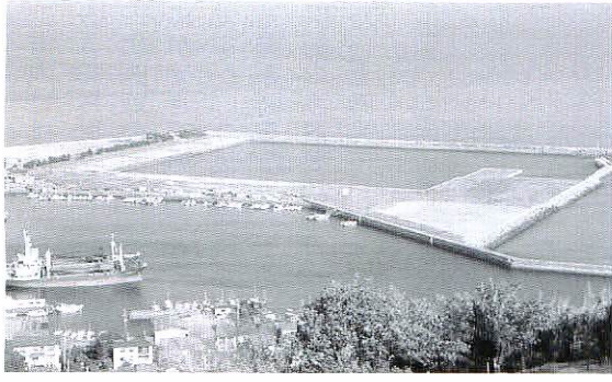
着々と整備が進む長浜港小型船だまり
