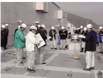
管内視察 肱北浄化センター建設工事
