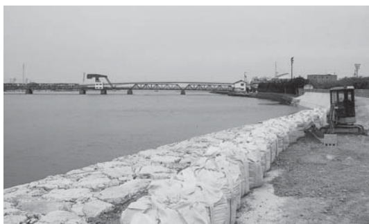
護岸工事が進む肱川河口周辺(長浜中学校 横)
