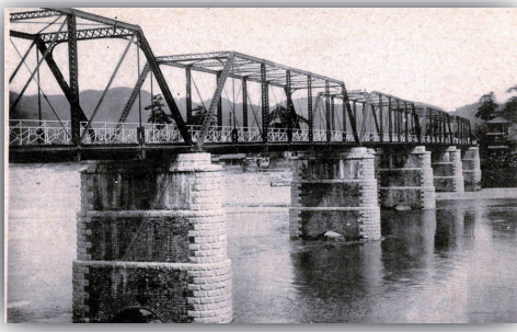
建設当時の肱川橋
