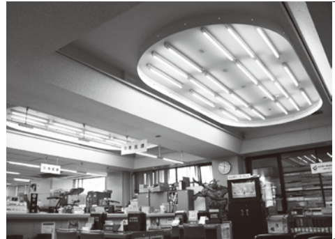
LED照明器具へ取り替えを行った市役所1階窓口
