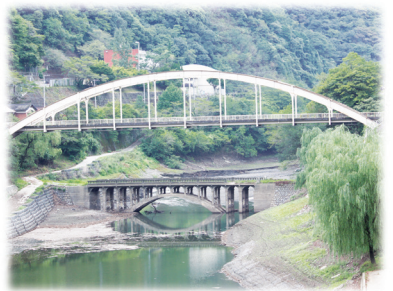
鹿野川湖が湯水のため現れた旧舟戸川橋(野村町坂石)
