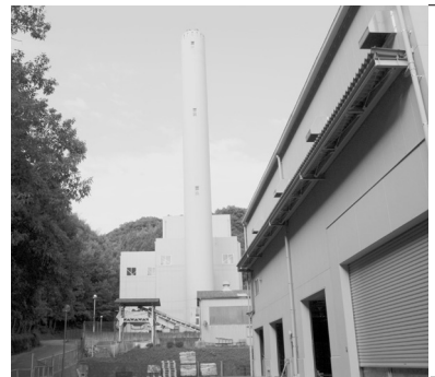
内山クリーンセンター（内子町）
