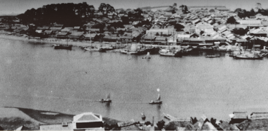
長浜大橋建設前
