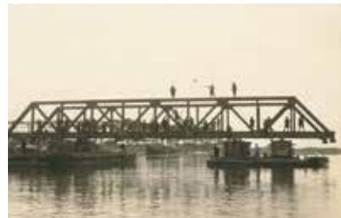
台船による橋桁の移送 写真提供:細野房雄氏
