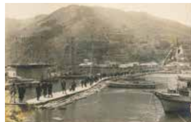
工事中に架けられた浮橋 写真提供:細野房雄氏
